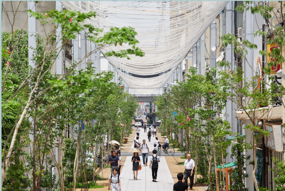
福山市本通・船町商店街アーケード改修プロジェクト -とおり町Street Garden- (Koji Fujii/Nacasa&Partners.Inc)
